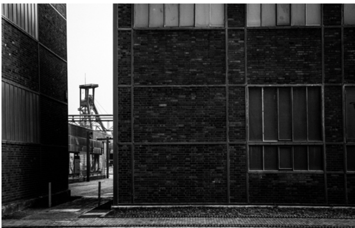
FIGURE 32: ZECHE ZOLLVEREIN, GELSENKIRCHENER STRASSE, ESSEN, DEUTSCHLAND
